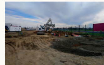
Aménagement de la ZA Barres 3
