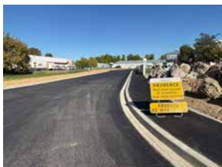
Coût travaux Chemin de la Chaumière : 226 000 euros TTC
