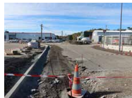
Coût travaux Rue des Pommes et la Rue des Cerises : 315 000 € TTC
