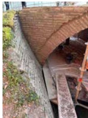
Pendant la phase de travaux
