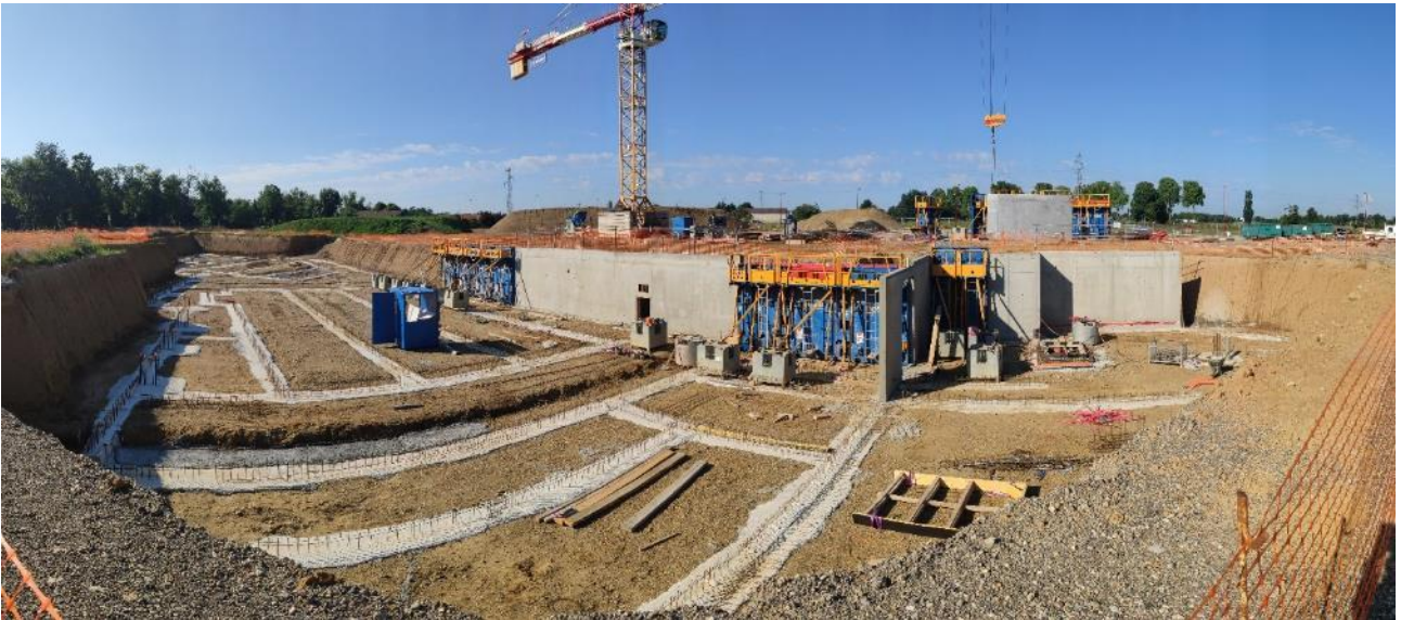
1er juillet 2021 : installation des voiles de protection
