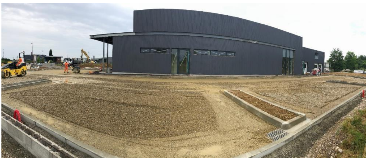
17 juin 2021 : aménagement des extérieurs
